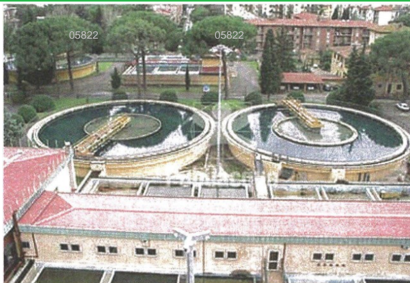
Via Villamagna L'acquedotto fiorentino dell'Anconella
